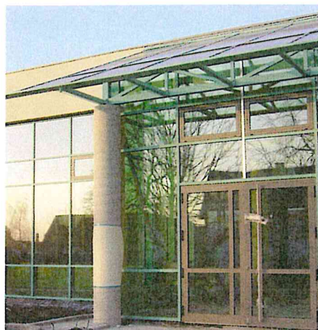
Lichtdurchflutete Sporthalle mit Niedrigenergiekonzept
